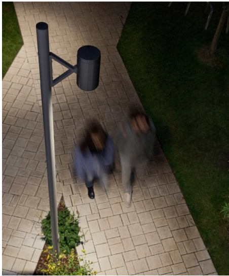
Tverrforbindelser: Tverrforbindelsene er presist lyssatt med armaturer som er godt avskjermet.
